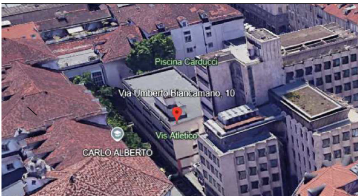
Vista impianto da Google earth
