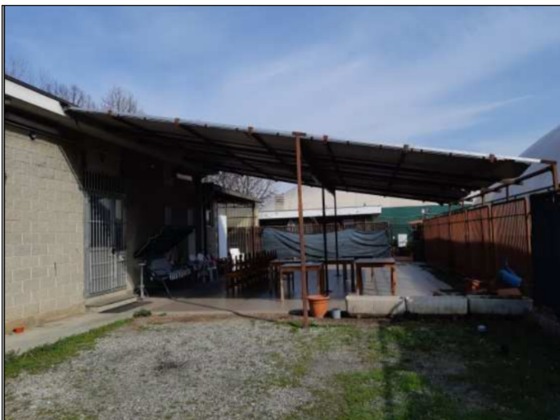
Vista generale impianto
