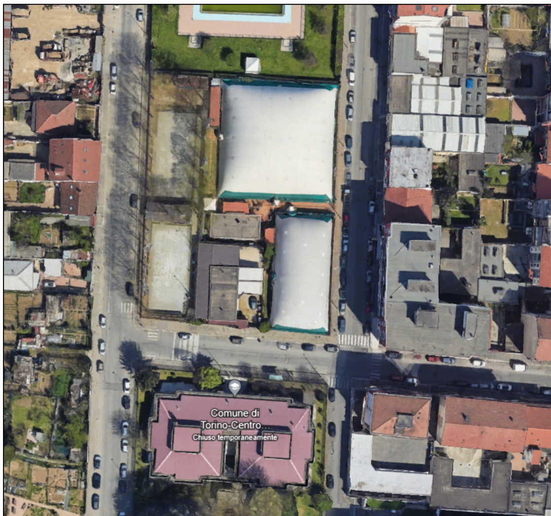
Vista impianto da Google earth
