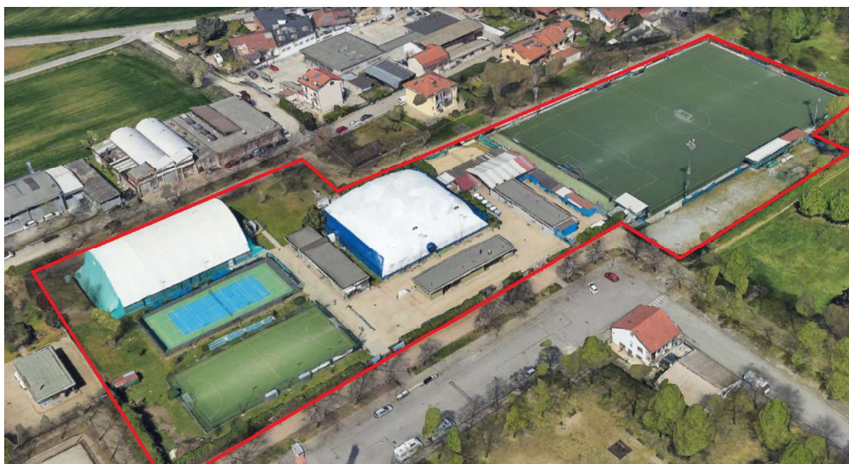
Vista aerea impianto da Google Earth
