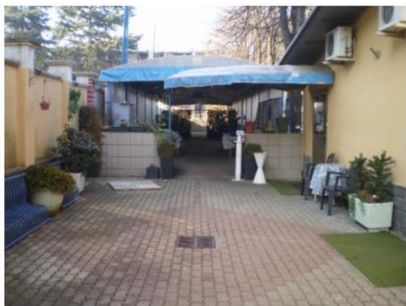
vista tettoia esterno e interno
