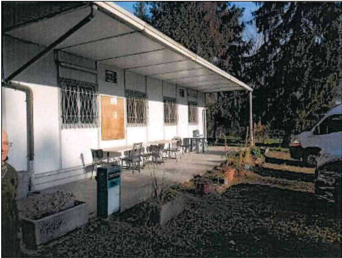
fabbricato principale - vista esterno
