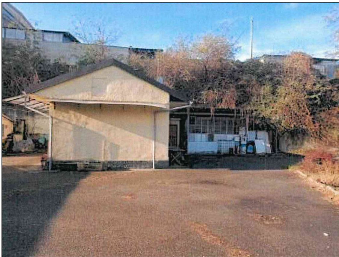
vista ex alloggio custode e locale magazzino e magazzino in struttura metallica
