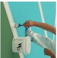
La pittura sia delle linee di tracciamento che della pavimentazione del campo sarà sintetica del tipo acrilico a base acqua, resistente all'usura, di colore a scelta della D.L.
