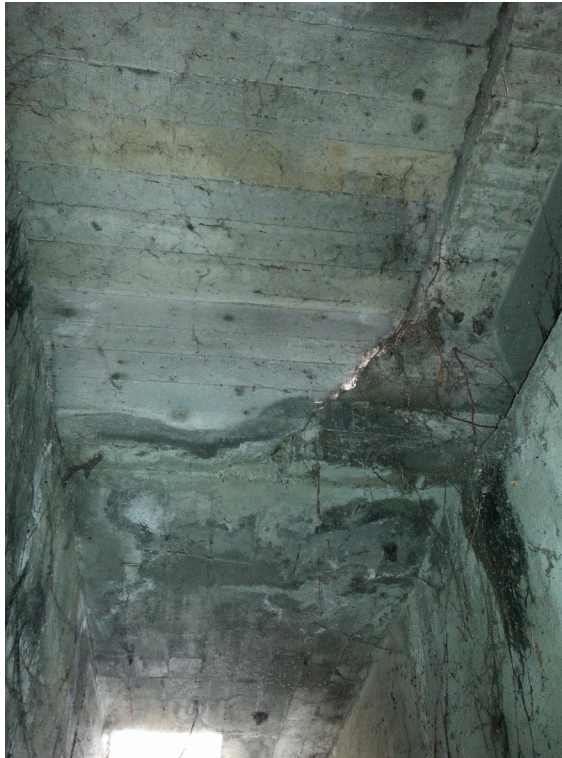
2. Foto: Vista dal basso della scala. Foto scattata dall'interno dell'intercapedine perimetrale dell'edificio scolastico
