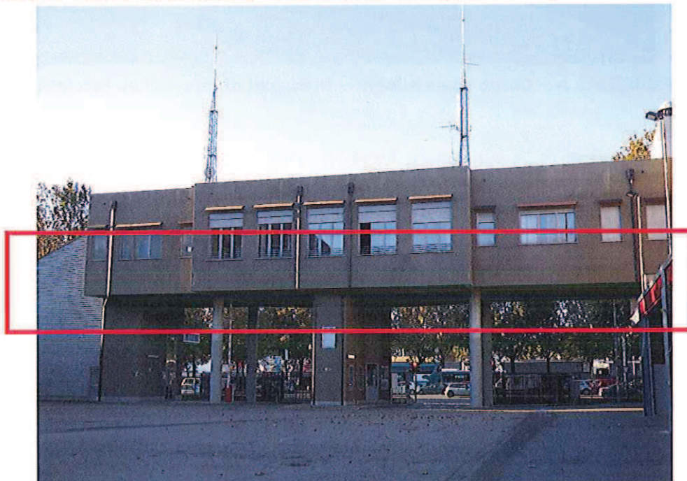
Foto 10 – Sala operativa fronte cortile – Serramenti vetrati su cui effettuare la manutenzione
