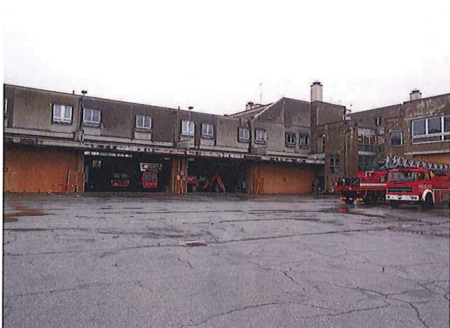
Foto 11-12 - Fabbricato B - Alcuni serramenti vetrati su cui effettuare la manutenzione
