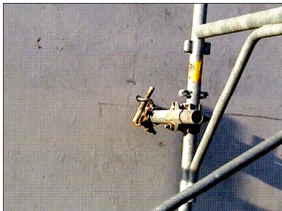
Ancoraggio con barra munita di gancio
