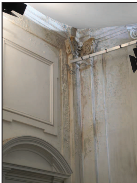
FOTO N.2 – Abside Centrale della Cappella dell'Ex Cimitero, particolate della lesena
