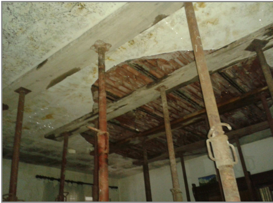
Ex Cimitero di San Pietro in Vincoli – Interventi di consolidamento da eseguirsi sul solaio dell'alloggio custode.
