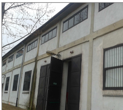
Magazzino Ex Superga – Interventi di interposizione inferriate metalliche sulle finestre del piano primo prospicienti il terrazzo e realizzazione di vespaio ventilato in alcuni ambienti del piano terra.
