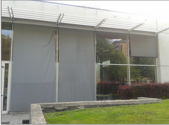
Biblioteca Civica Villa Amoretti e Aranciera – Interventi di ripristino della funzionalità delle tende del nuovo padiglione.
