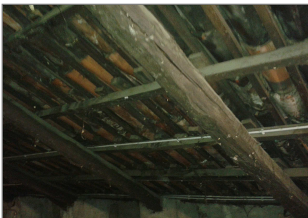
Ex Cimitero di San Pietro in Vincoli – Interventi sul manto di copertura in coppi e revisione delle faldalerie..
