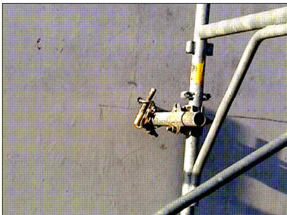
Ancoraggio con barra munita di gancio
