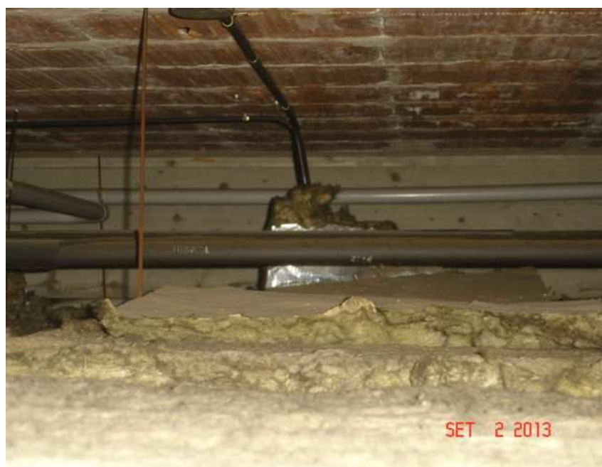
foto 5: particolare materiale isolante
