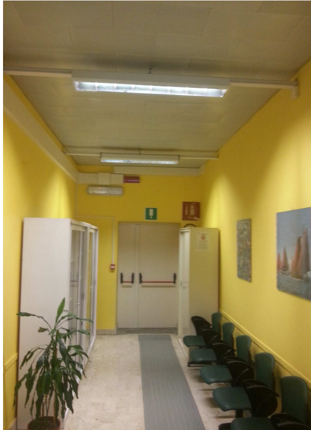
foto 1: corridoi locali piano primo
