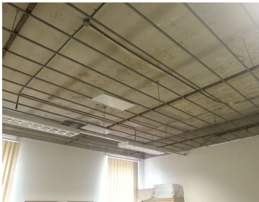
foto 6: particolare locale già oggetto d'intervento
