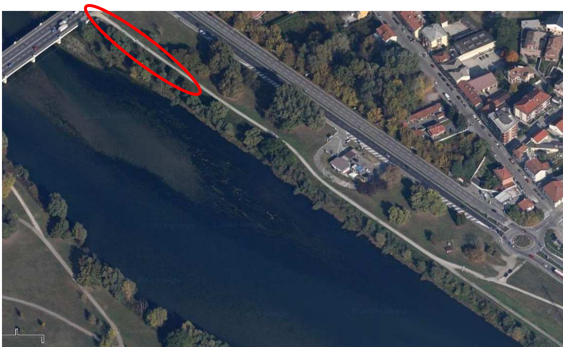
Fiume Stura di Lanzo. Assesamenti del profilo di sommità della sponda sinistra (cerchiato in rosso) nel tratto di valle del ponte di str. Settimo, riprofilata a seguito dell'evento alluvionale dell'ottobre 2000. Visibile a valle del ponte parte del materiale di deposito alluvionale.
