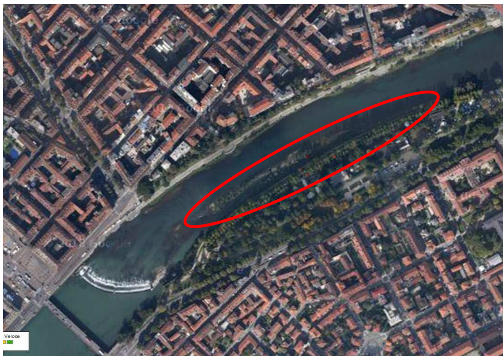
Fiume Po. Isola di materiali di deposito litoide (cerchiata in rosso) in corso di colonizzazione da parte della vegetazione spontanea a valle della traversa Michelotti, in sponda destra.
