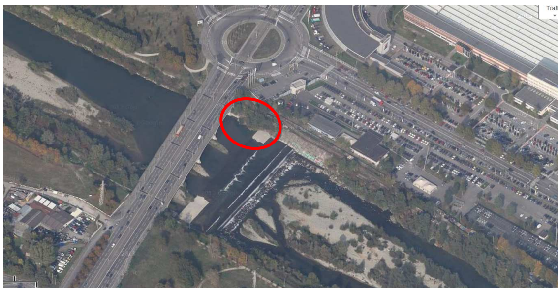
Fiume Stura di Lanzo. Tratto di mantellata in massi di cava in stato di dissesto (cerchiata in rosso) in sponda sinistra a valle del ponte di C.so Giulio Cesare. Visibile la diffusa presenza di isole di materiali litoide di deposito alluvionale a valle del ponte.
