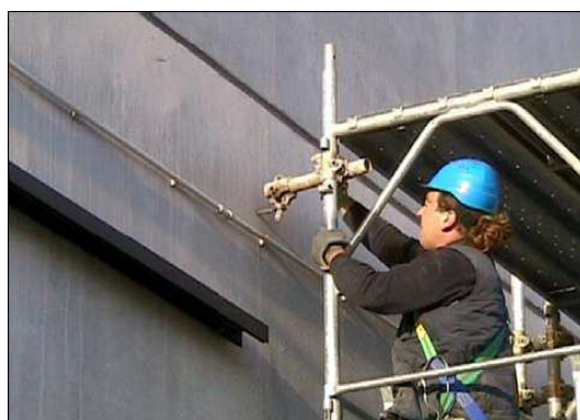
Ancoraggio con barra munita di gancio
