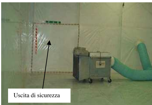
sistema di estrazione dell'aria
