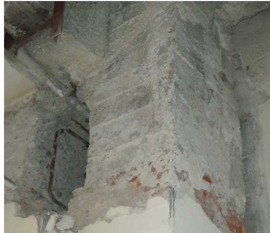
Rimozione intonaco su porzioni strutturali per evidenziare la connessione trave – pilastro - muratura
