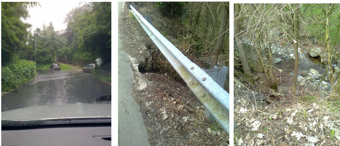
In questo caso il ciglio di valle coincide con l'argine del corso d'acqua sottostante, quindi l'opera dovrà partire dall'alveo in continuità con l'argine in cemento esistente subito al fianco. E' stato previsto un muro di pietrame e malta in continuità con quello di cemento in modo da portare gradualmente la verticalità dell'esistente verso un paramento inclinato costituito da una scogliera di massi ciclopici a protezione dall'erosione dell'argine, che costituiranno il prosieguo dell'opera.
