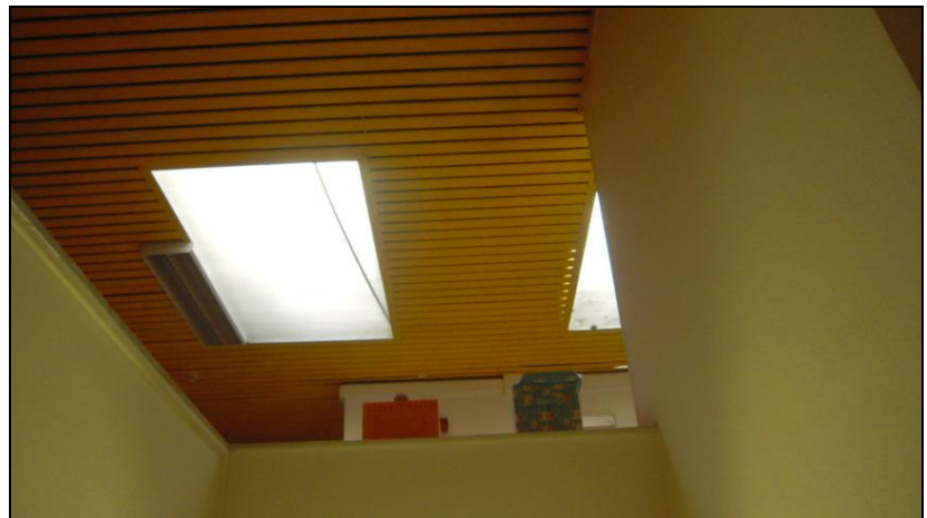
controsoffitti in doghe metalliche vano scale
