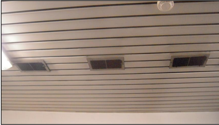
controsoffitti in doghe metalliche sezione
