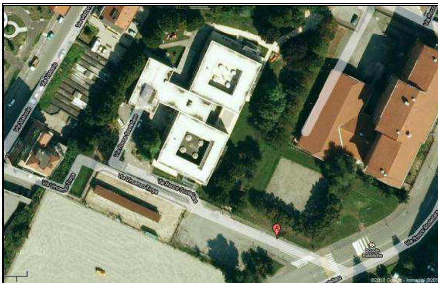
vista area edificio
