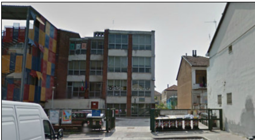
vista carraio via Venaria 79/15
