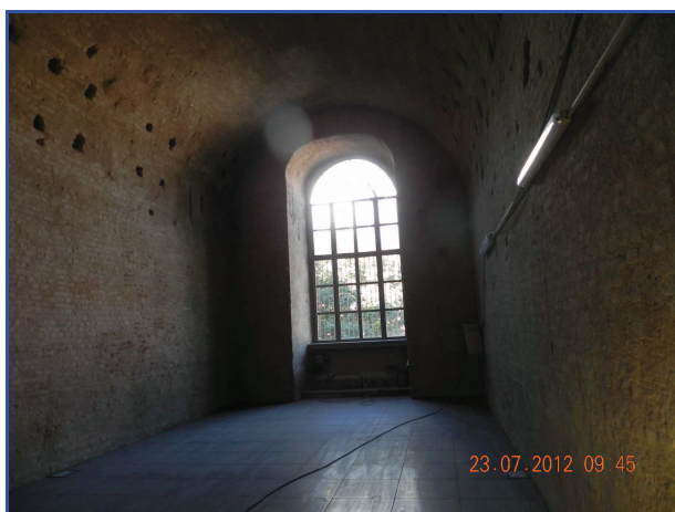
LOCALE 301 piano primo
