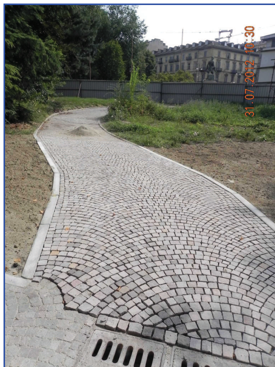
PARTICOLARE DELLA PAVIMENTAZIONE IN PORFIDO AREE ESTERNE
