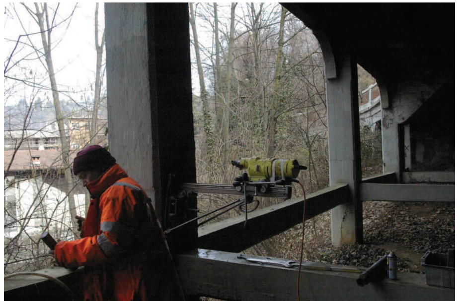
carotaggio n. 3 su pilastro di bordo
