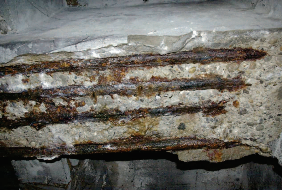
4Ø28 inferiori dritti all'appoggio trasverso
