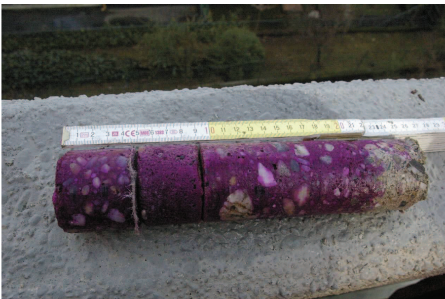
Carotaggio 2- soletta - Carbonatazione ÷4 cm all'intradosso
