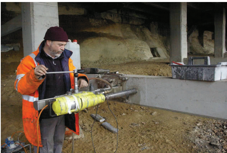
Carotaggio 4 su trave di collegamento pilastri
