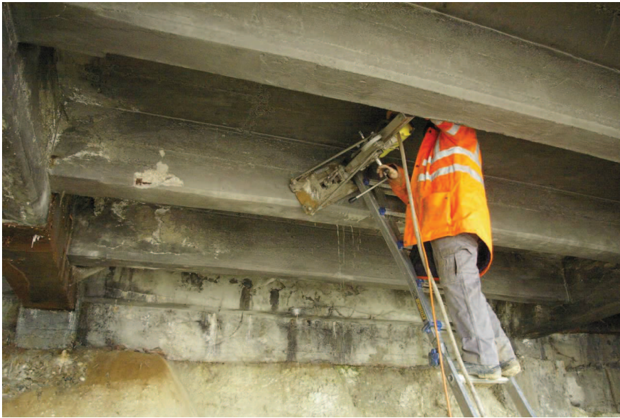
carotaggio 5 su trave impalcato
