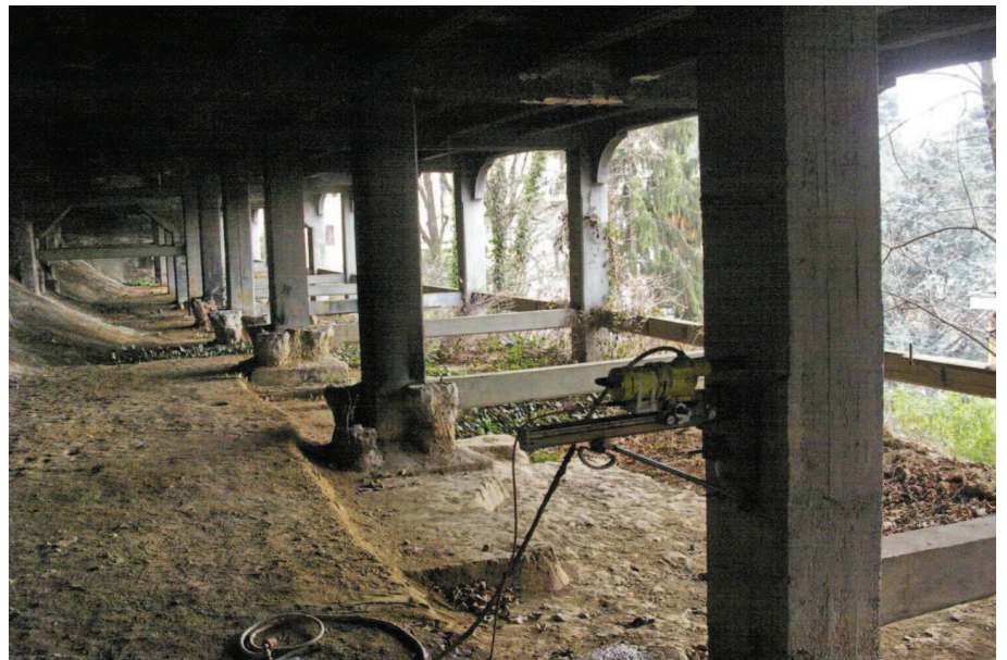
esecuzione carotaggio 7 su pilastro interno
