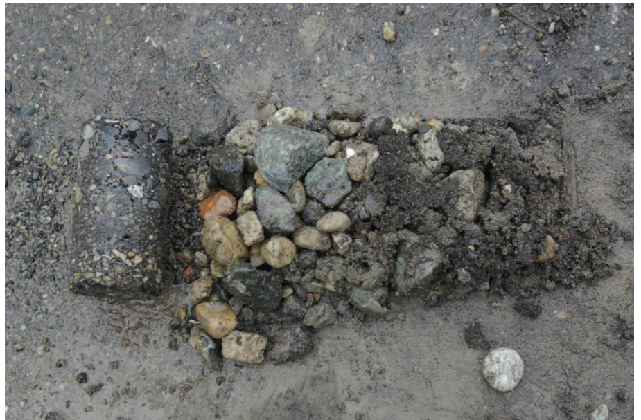
materiale di sottofondo pavimentazione stradale
