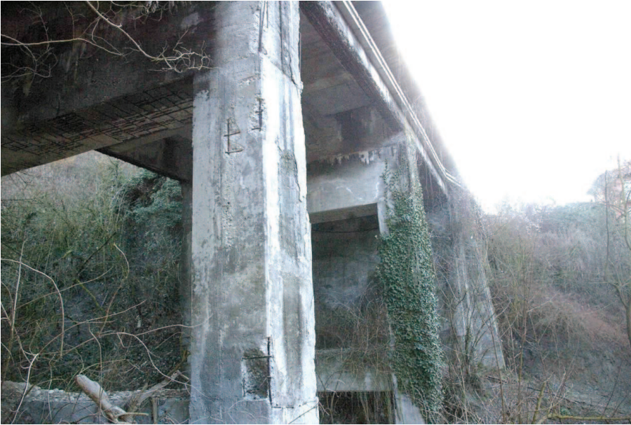
strutture ponte viste da valle
