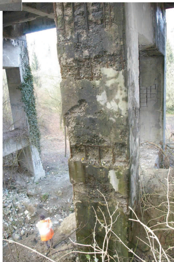
pilastro monte 1 a pila
