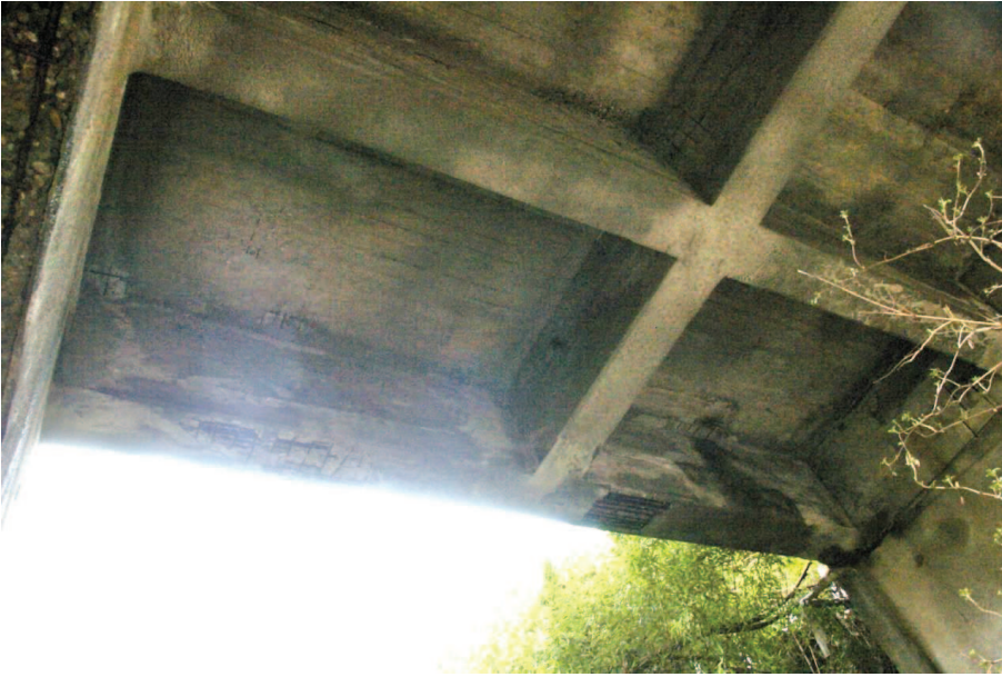
2 a campata trave di monte
