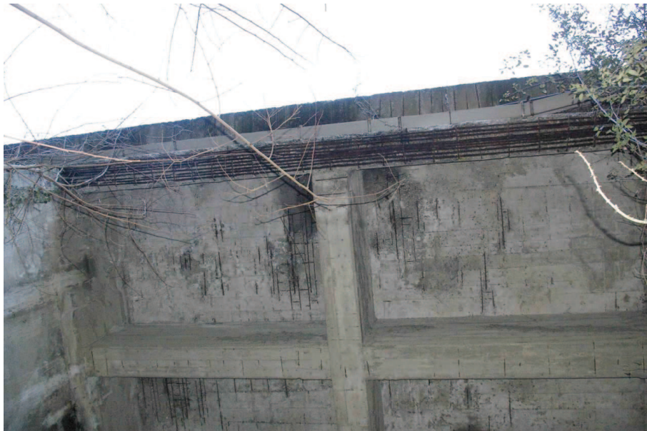
intradosso 3 a campata verso valle
