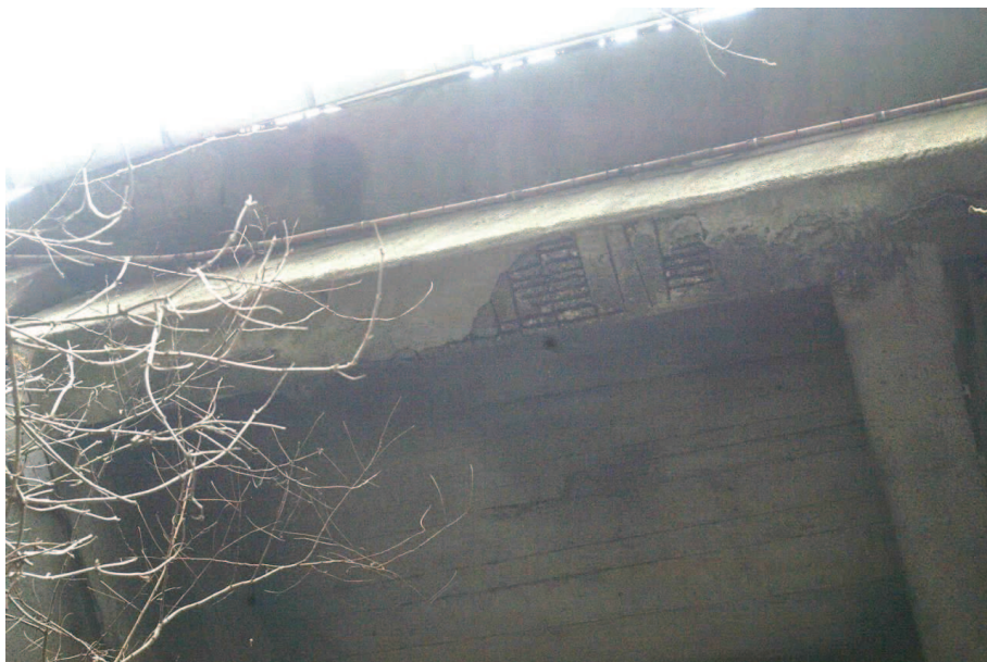
particolare 1ª campata trave di valle
