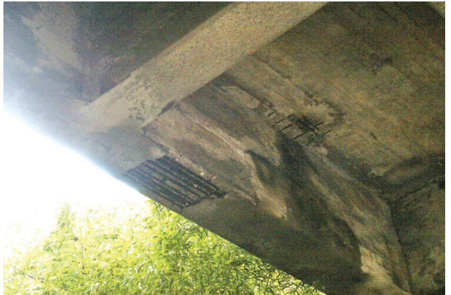
2 a campata trave di monte
