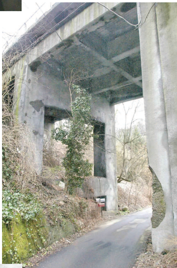
campata 1 vista da monte
