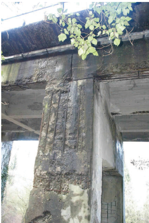
pilastro monte 1 a pila
