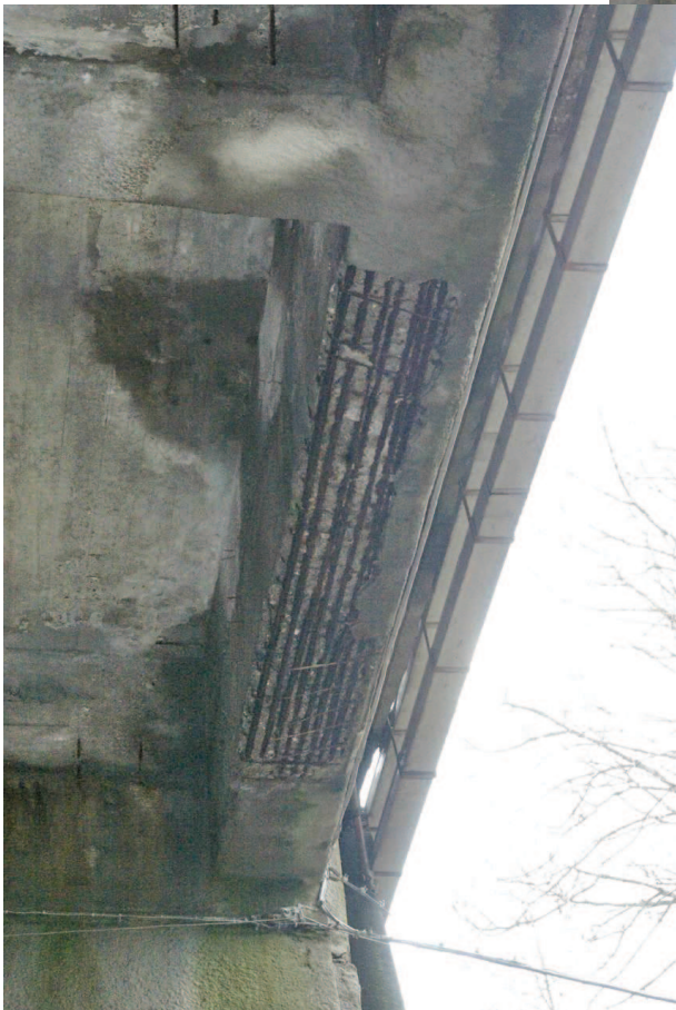
particolare 2ª campata trave di valle
