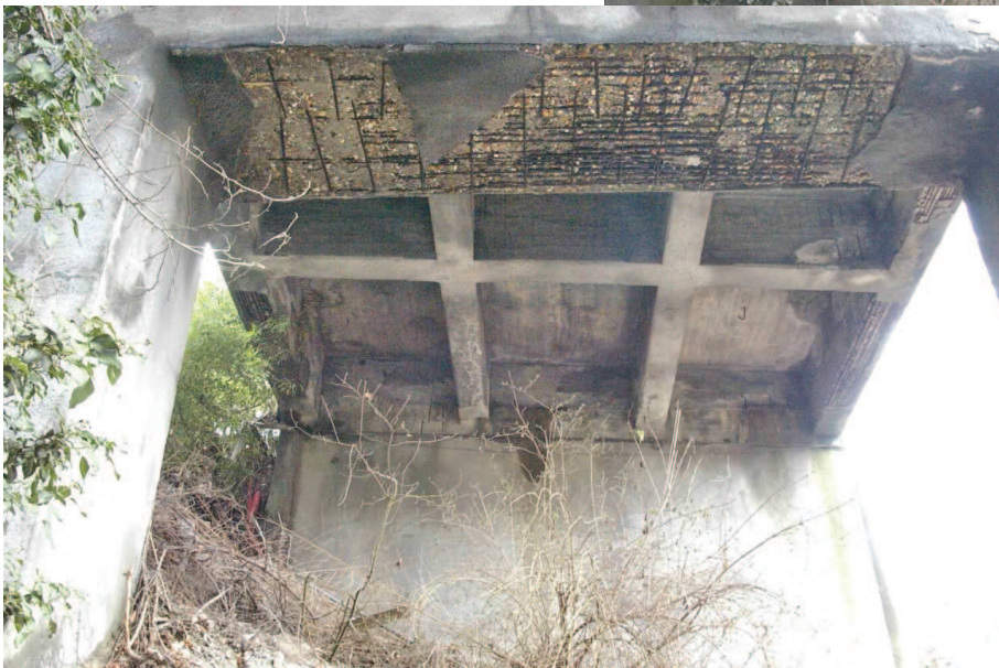
intradosso pulvino e vista intradosso impalcato 2 a campata
