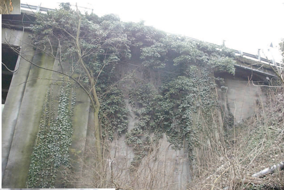
muroi andatore a valle in sinistra
