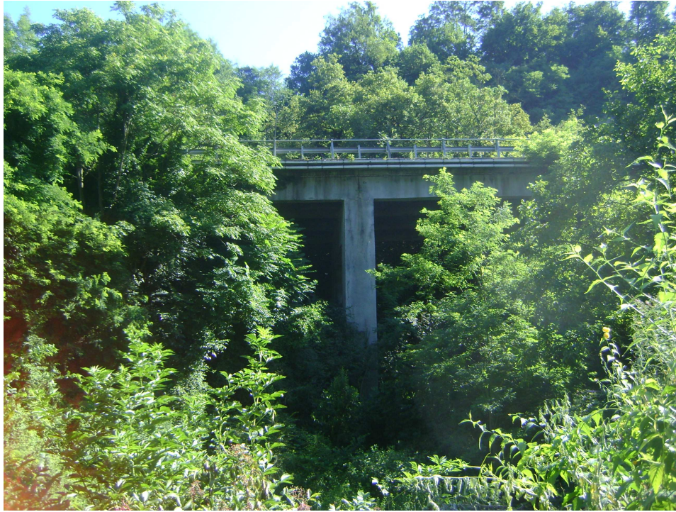
Foto 1 – Difficoltà di accesso alle infrastrutture
