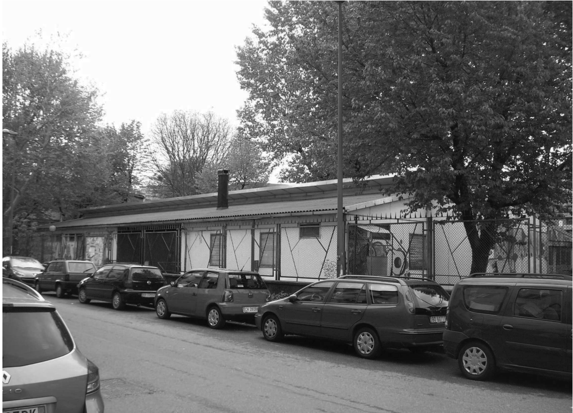
FOTO N. 3 - EDIFICIO "C" VISTA DA VIA REVELLO
