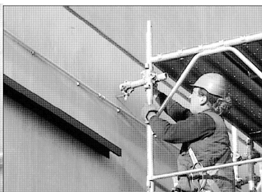
Ancoraggio con barra munita di gancio
