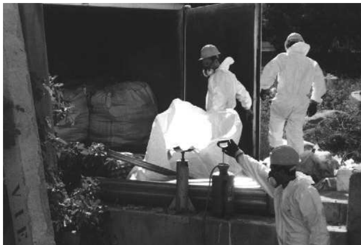
Deposito temporaneo dei materiali in container
