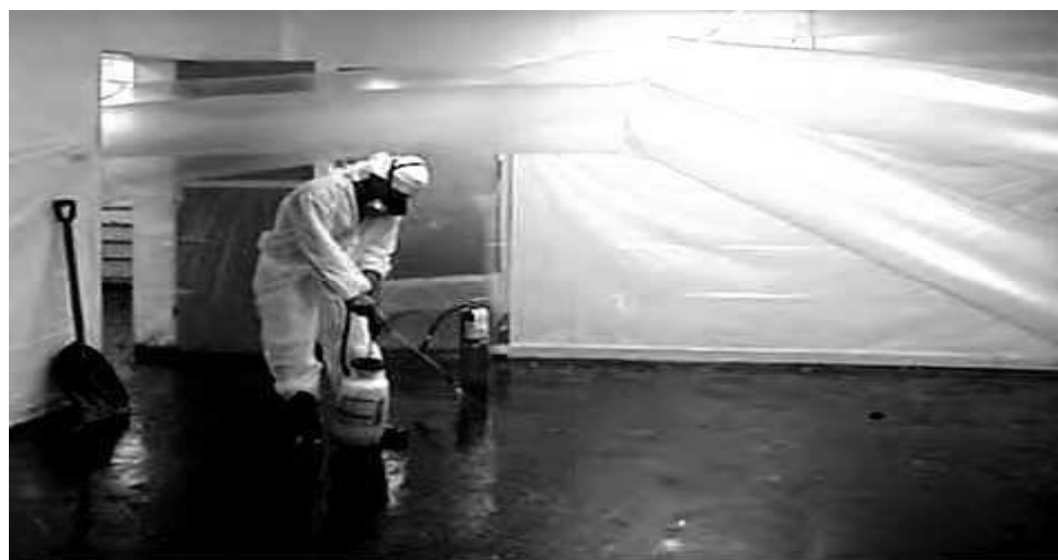
Esempio di confinamento statico e dinamico
