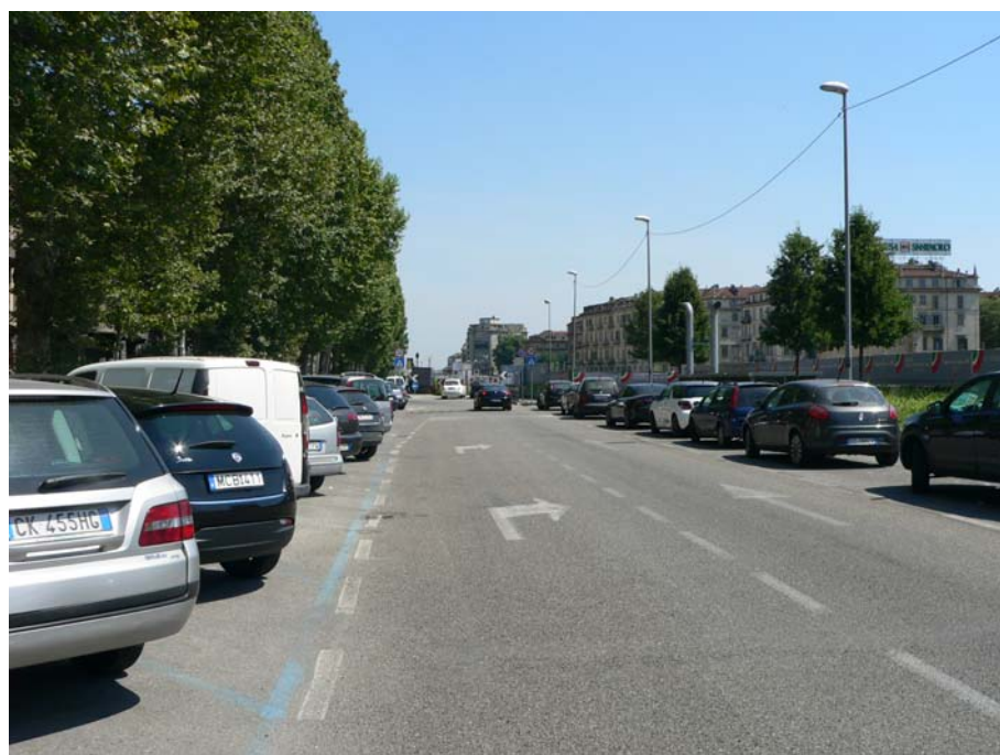
Foto 8 – rampa sud verso Corso Inghilterra
