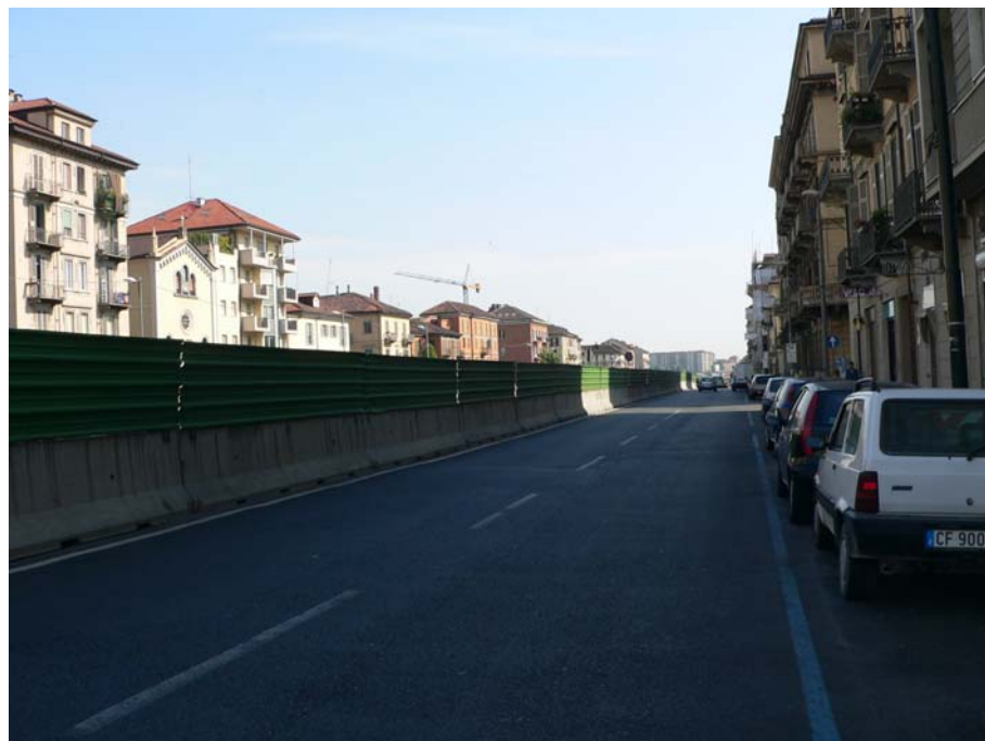
Foto 3 - carreggiata laterale est corso P. Oddone
