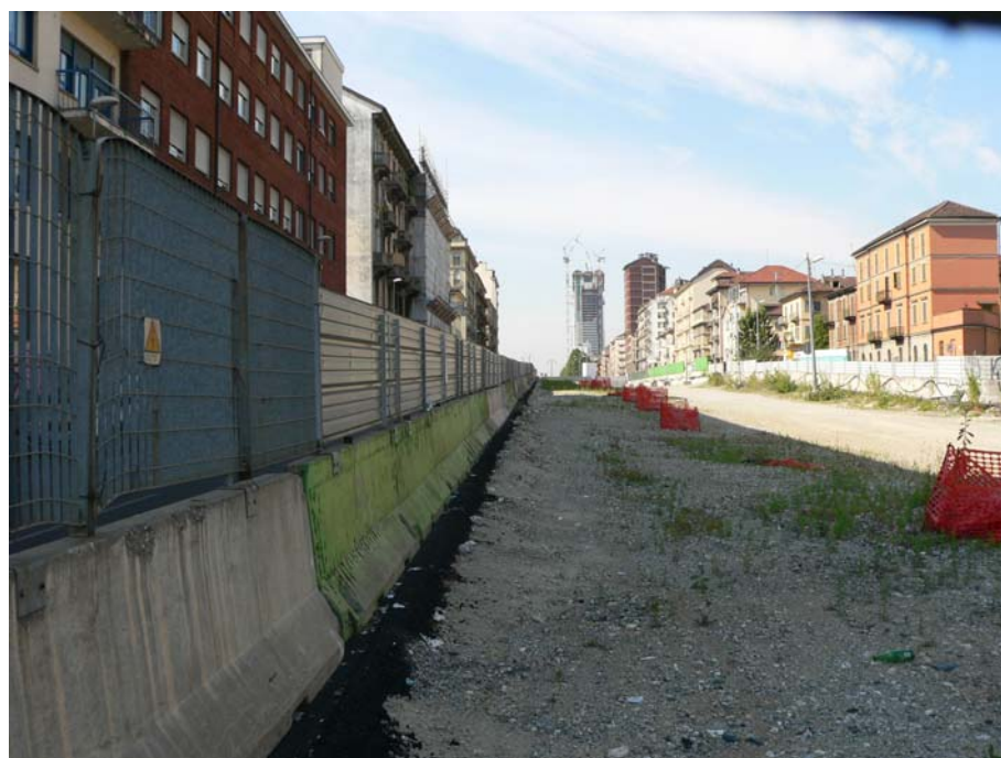
Foto 4 - rampa nord verso corso Regina Margherita
