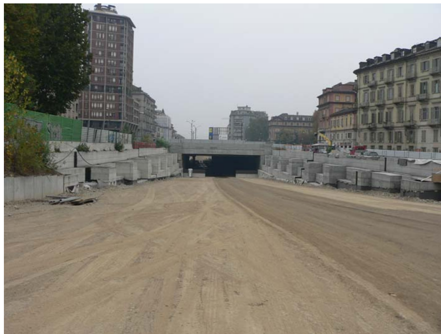
Foto 1 - rampa sud sottopasso Statuto
