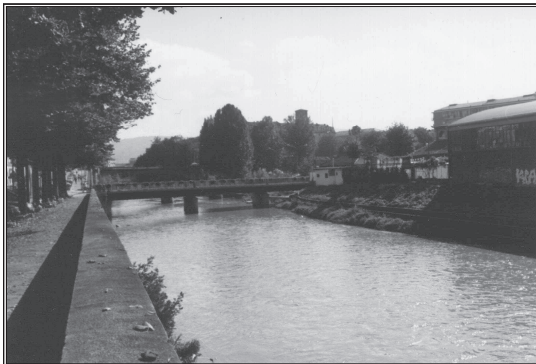
Figura 3-6 - Ex ponte Principessa Clotilde, demolito dopo i danni subiti durante la piena dell'evento dell'ottobre 2000, visto dalla passerella di Via Mondovì.
