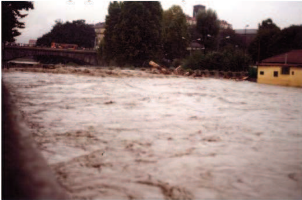
Figura 2-8 - Figura 73. Sullo sfondo il ponte Mosca da monte (sez 5.1P) (fonte: CSI Piemonte, http://www.csi.it/ ). La corrente ha superato il ponte Principessa Clotilde la cui pila destra è già crollata. Sulla destra della foto, l'edificio della società bocciolina.
