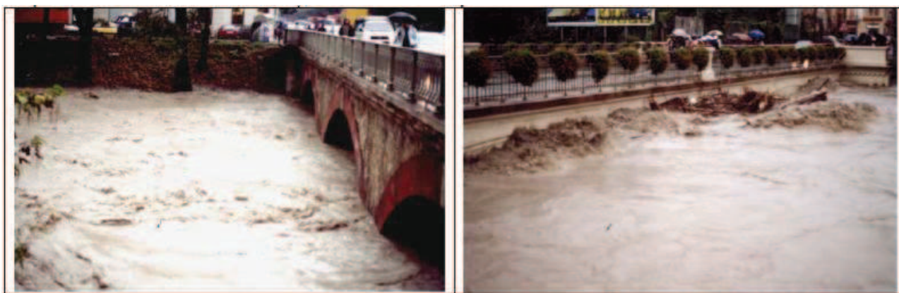
Figura 2-7 - Figura 72. Ponte Alberto del Belgio (sez 7.1Pa) in sinistra (Corso principe Oddone, paramento di valle); Pte Duca degli Abruzzi 6.2P in destra (Via Cigna, vista da monte) (fonte: CSIPiemonte, http://www.csi.it/ )
