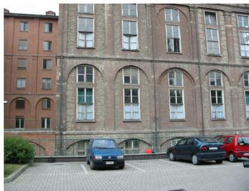
largamente alleggeriti da grandi aperture di finestre e porte-finestre e addensati in pilastri in corrispondenza dei nodi della griglia, ma ancora strutturalmente collaboranti. Gli orizzontamenti sono costituiti non mediante una gerarchia di volte poggianti su archi e questi sui pilastri (come era nella pratica convenzionale: ad esempio nell'Ospedale dei
