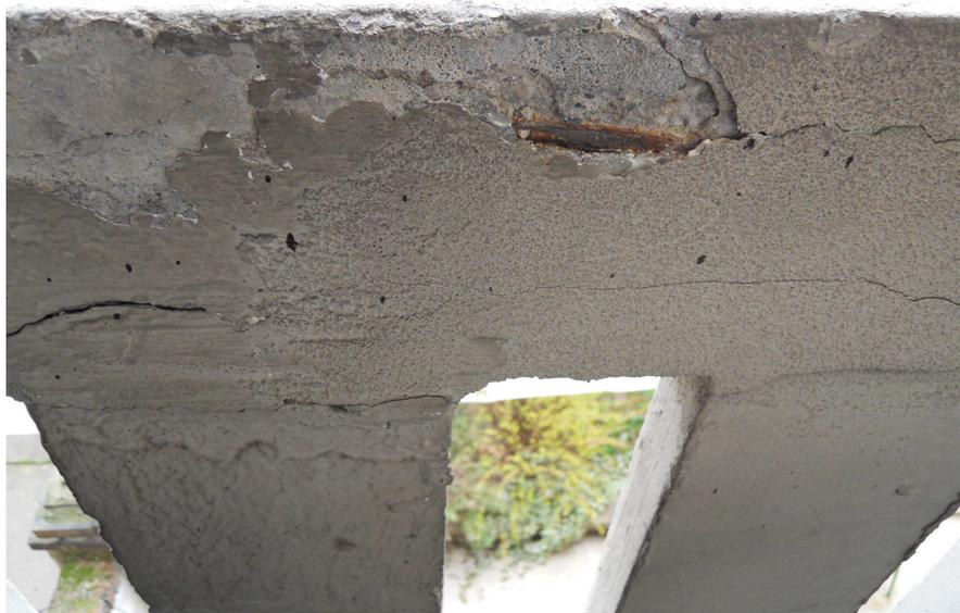
**Particolare del parapetto del balcone ammalorato.**
