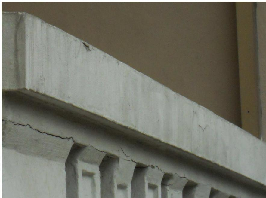
**Particolare del parapetto del balcone ammalorato.**
