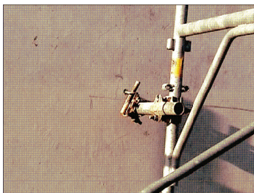
Ancoraggio a barre filettanti passanti dotate di piastre di contrasto
