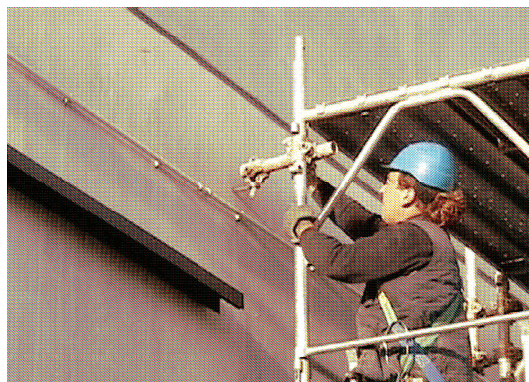
Ancoraggio con barra munita di gancio
