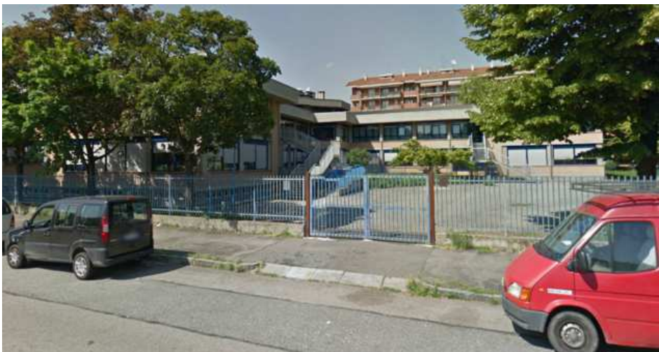
Ingresso carraio via Pasubio
