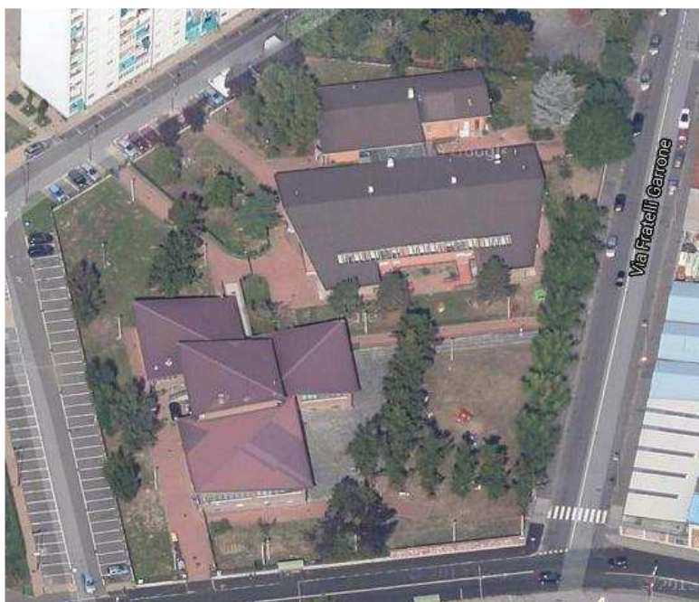
vista aerea generale
