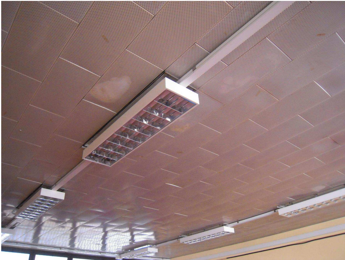
Foto 5 – piano rialzato – porzione di controsoffitto in pannelli metallici forati
