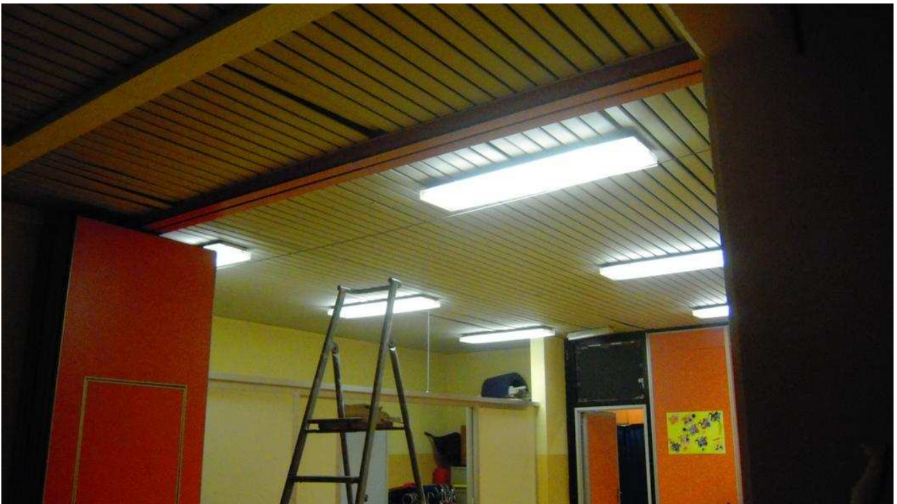
Foto 8 – piano rialzato – locali del C.E.S.M. oggetto d'intervento
