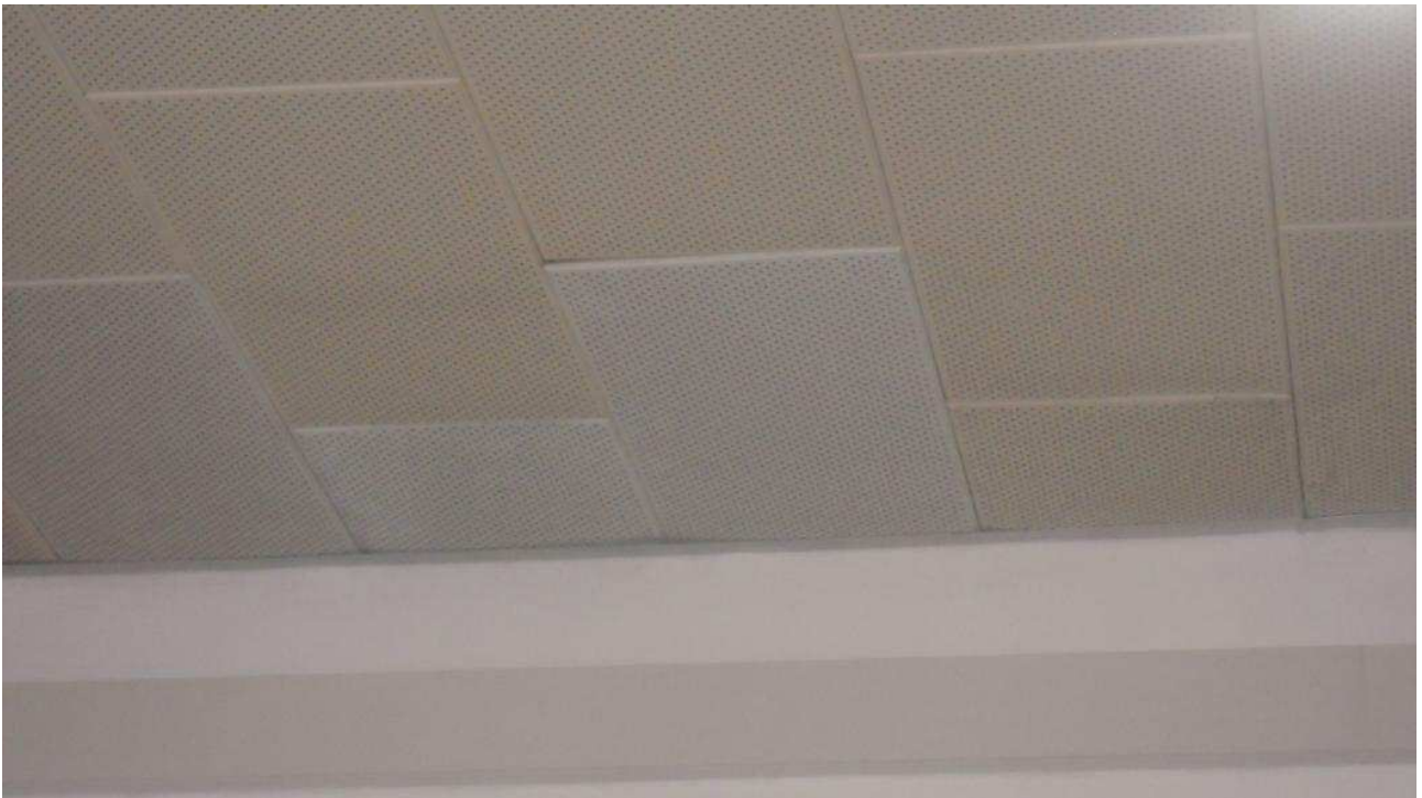
Foto 18 – piano rialzato – controsoffitto metallico forato
