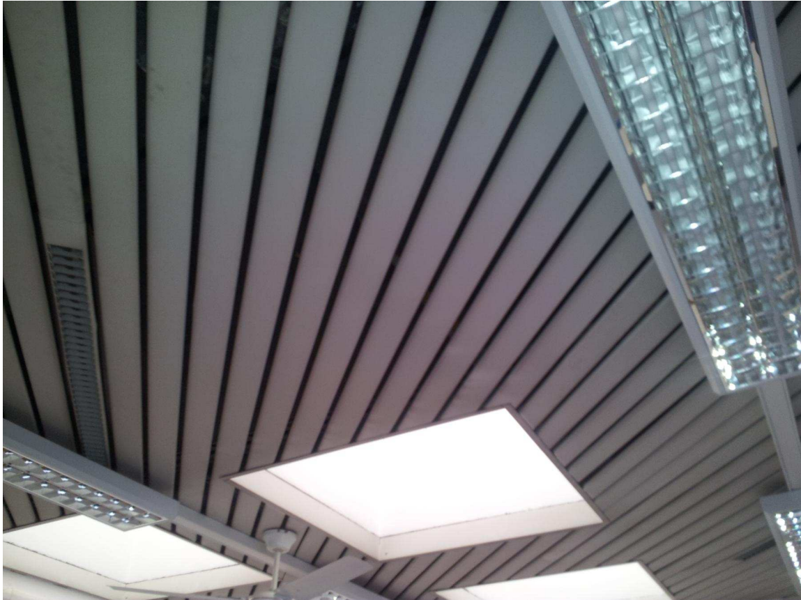
Foto 3 – piano rialzato – controsoffitto in doghe di alluminio presente nell’aula linguistica
