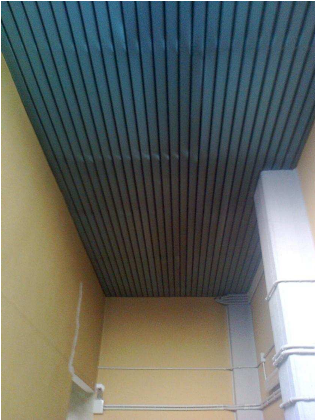
Foto 20 – piano rialzato – controsoffitto in doghe metalliche
