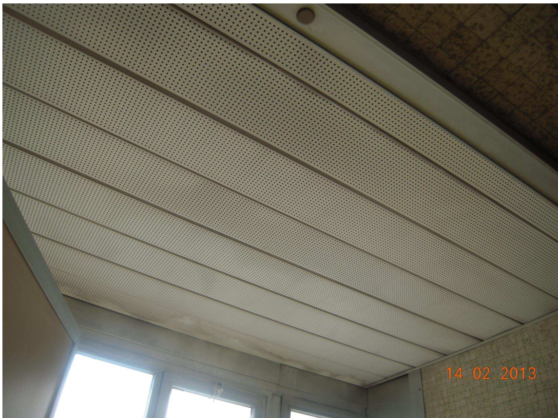
Foto 24 – piano primo – particolare del controsoffitto in doghe metalliche forate
