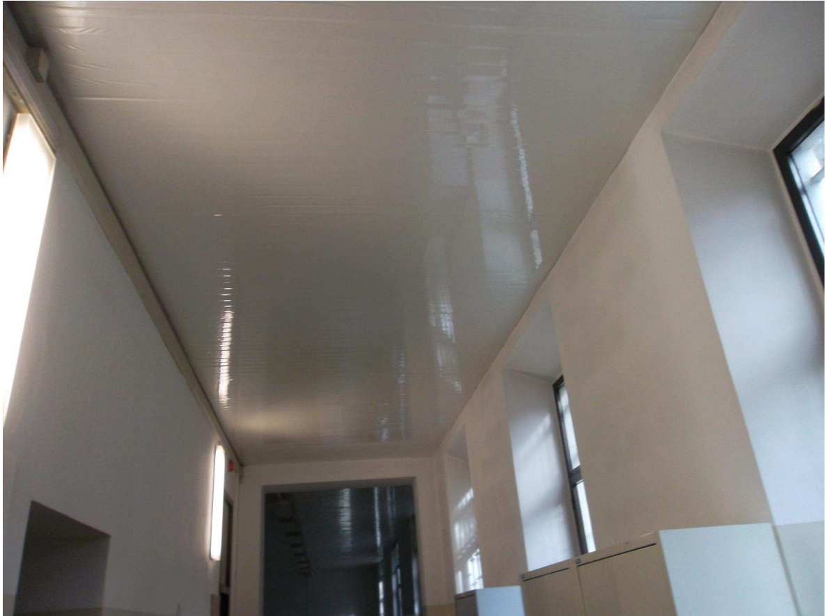
Foto 11 – piano rialzato – disimpegno fronte refettorio
