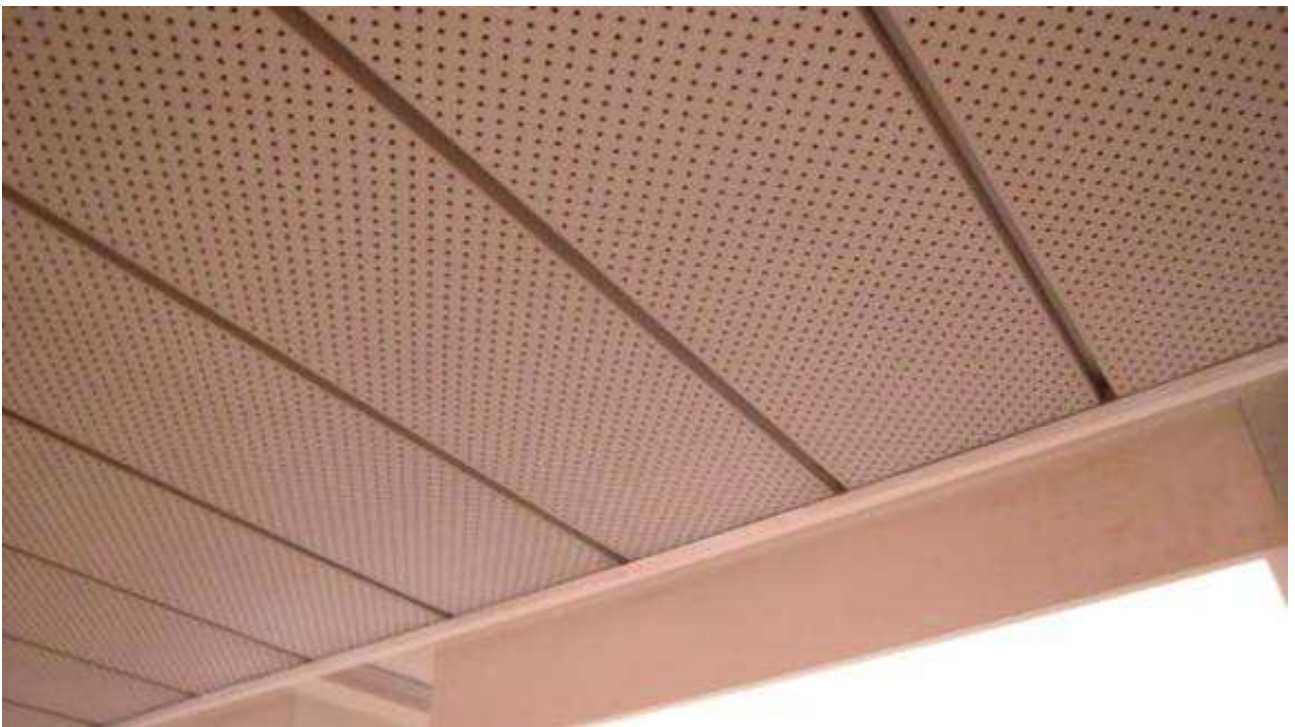
Foto 2 – piano rialzato – controsoffitto in doghe di alluminio presente nella zona destinata ad attività speciali
