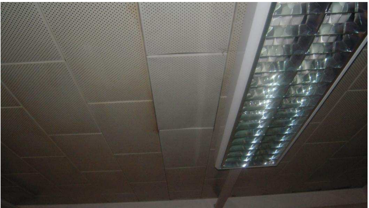
Foto 19 – piano rialzato – controsoffitto metallico forato
