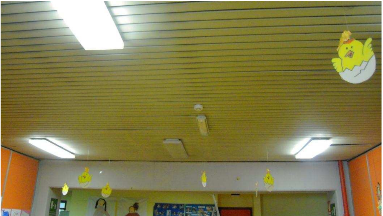
Foto 7 – piano rialzato – porzione di controsoffitto in doghe di alluminio
