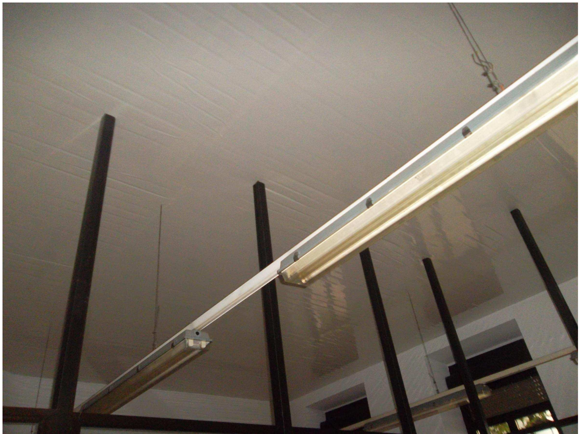
Foto 10 – piano rialzato – locale preparazione pasti
