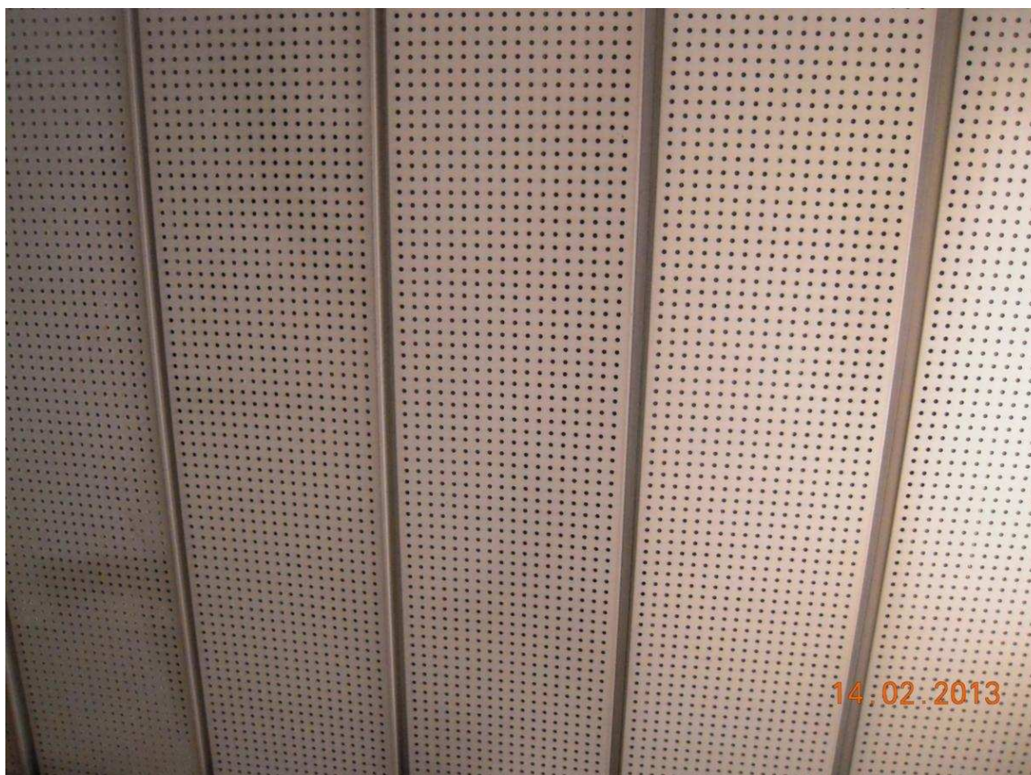
Foto 22 – piano rialzato – particolare del controsoffitto in doghe metalliche forate
