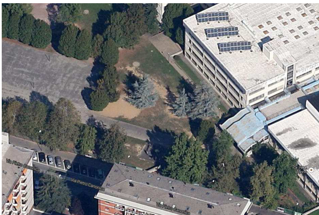
vista area di cantiere
