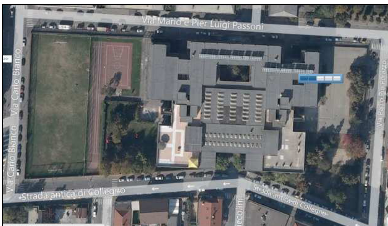
Vista aerea intero complesso scolastico
