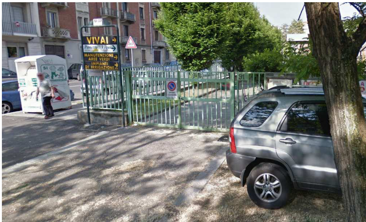
vista ingresso cortile area di cantiere
