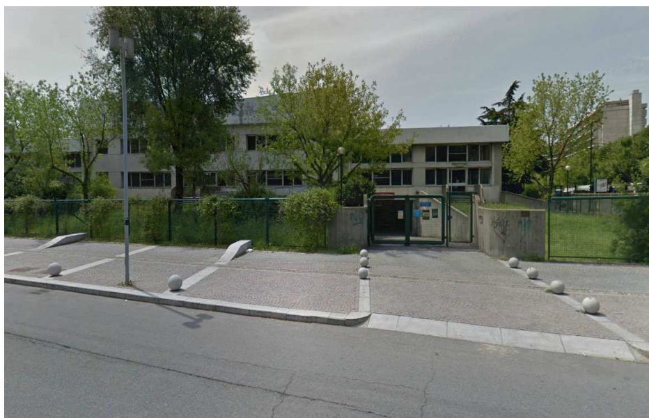
vista ingresso via Gaidano 79
