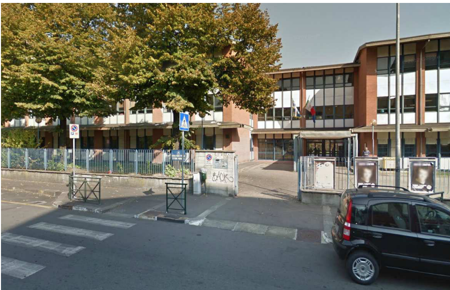
vista ingresso scuola secondaria di primo grado
