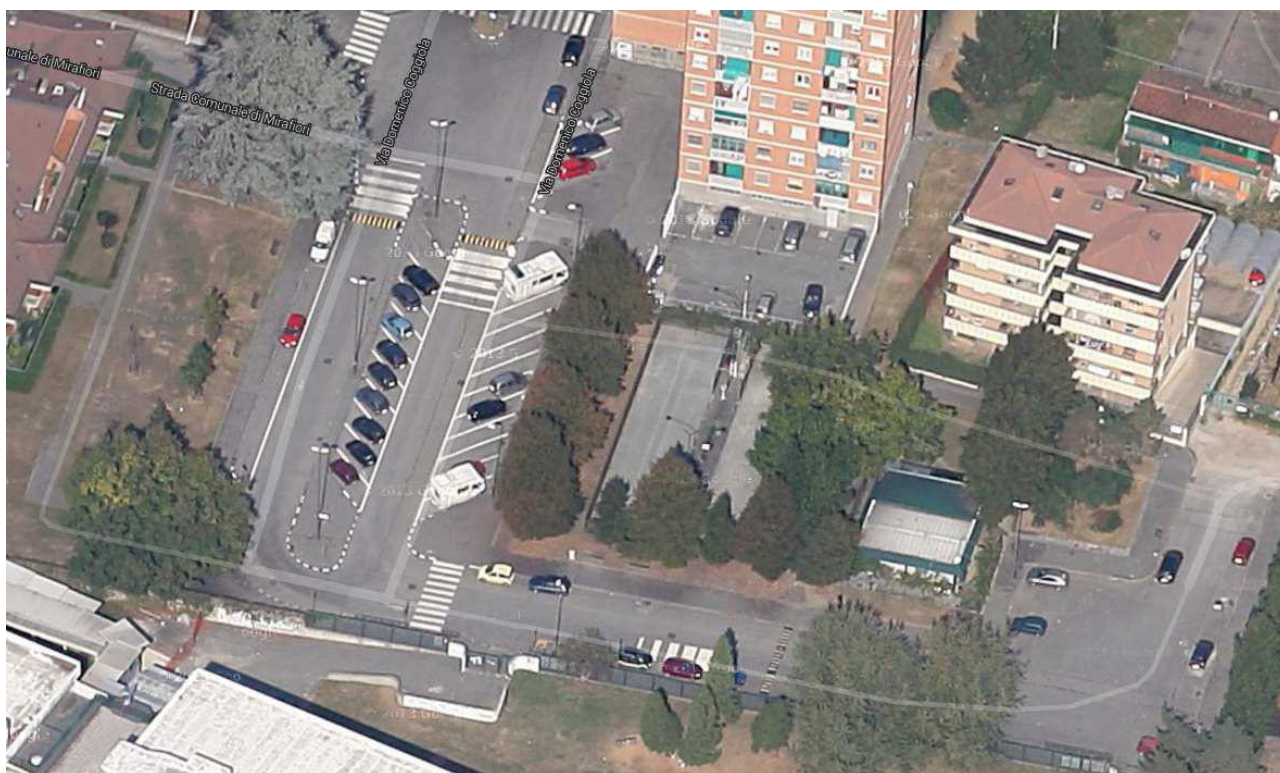
vista aerea via Coggiola
