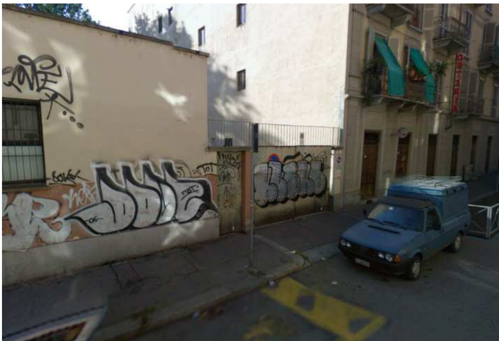
vista ingresso area di cantiere su via Guastalla
