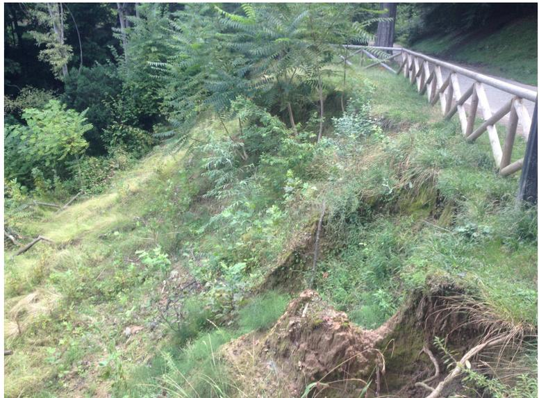
Il dissesto ha coinvolto il terrapieno (in parte costituito da terreno di riporto) che bordava il ciglio di valle della suddetta strada interna. Il dissesto ha altresì causato la traslazione e il ribaltamento degli alberi ad alto fusto ivi sussistenti e il crollo di parte della palizzata lignea esistente a valle della strada interna al parco: palizzata attualmente ricostruita più a monte in aderenza al ciglio di valle della strada (come osservabile nella foto alla pagina precedente).
