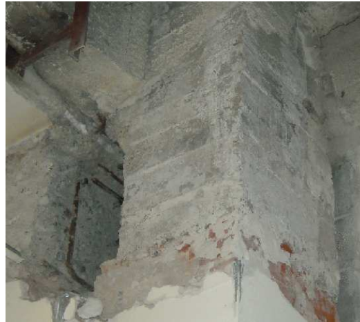
Rimozione intonaco su porzioni strutturali per evidenziare la connessione trave – pilastro - muratura
