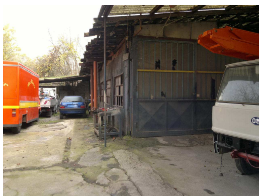
vista su volumi in demolizione
