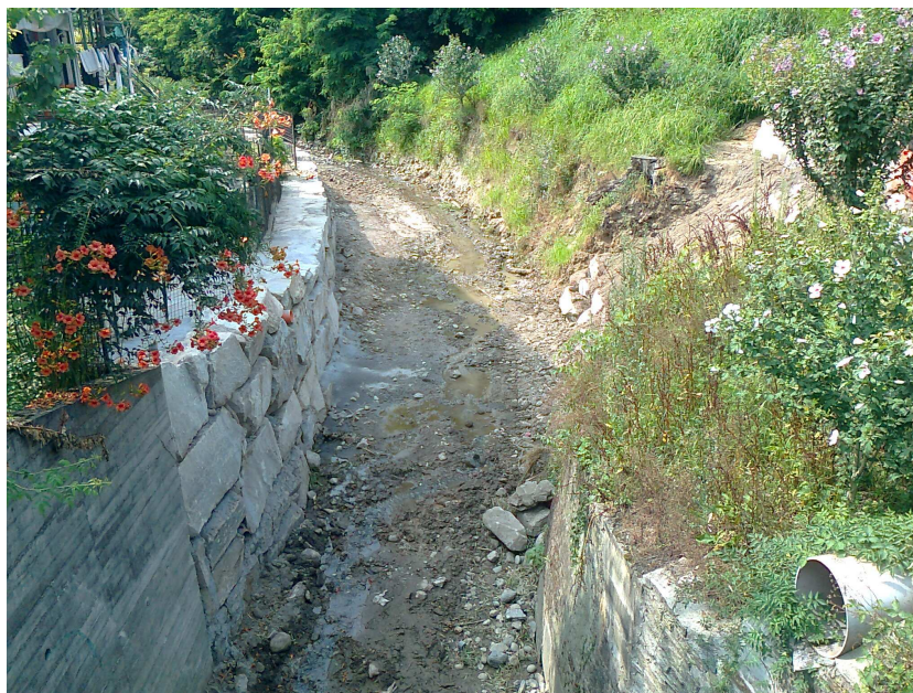
Rio Costa Parigi in c.so Casale, intervento urgente realizzato nel luglio 2012 dal Comune di San Mauro sulla sponda destra e ripristino della sponda sinistra (utilizzata per l'accesso temporaneo in alveo) nell'area a Parco naturale della collina di Superga
