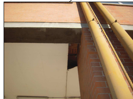
Cod. scheda 3.1.2 - 3.1.3 Rifacimento controsoffittatura zona ingresso
