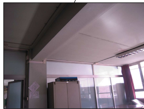
Cod. scheda 3.1.2 - 3.1.3 Rifacimento controsoffittatura zona ingresso
