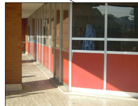
Cod. scheda 3.4.3 - Sostituzione serramenti Realizzazione nuovi parapetti in muratura
