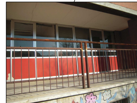
Cod. scheda 3.4.3 - Sostituzione serramenti Realizzazione nuovi parapetti in muratura
