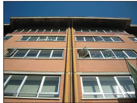
Cod. scheda 3.2.1 - Sostituzione discese pluviali Ripristino cornicioni
