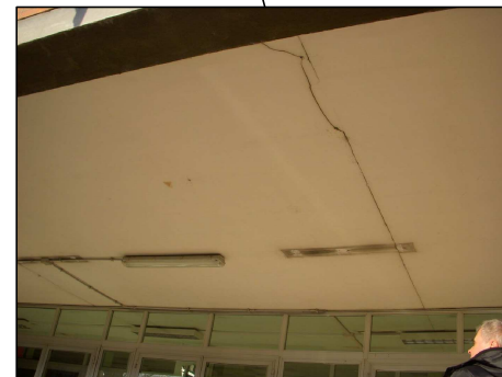
Cod. scheda 3.1.2 - 3.1.3 Rifacimento controsoffittatura zona ingresso
