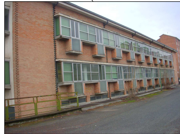
Cod. scheda 3.2.1 Adeguamenti davanzali con installazione di rialzamenti in metallo
