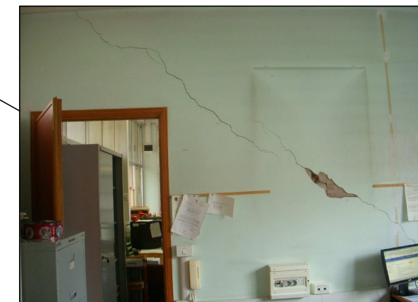
Cod. scheda 3.3.1 Demolizione e ricostruzione tramezzo
