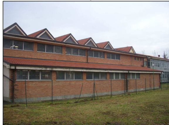
Cod. scheda 3.4.3 Sostituzione di serramenti esterni con nuovi a taglio termico
