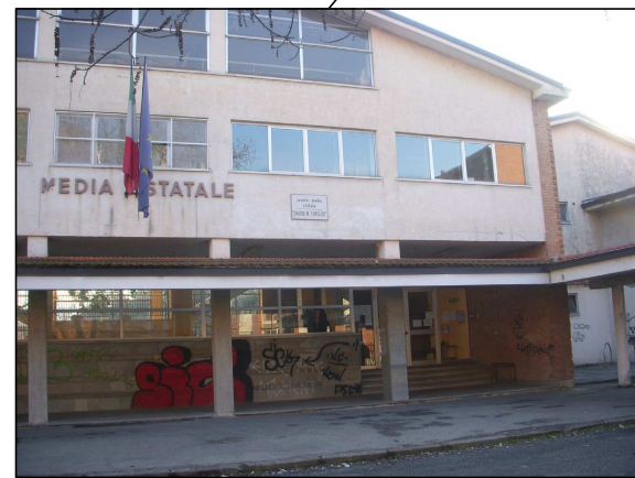
Cod. scheda 3.2.4 Spicconatura delle parti ammalorate Rifacimento intonaco e tinteggiatura
