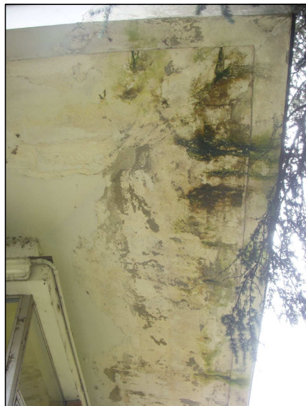
Cod. scheda 3.2.2 - Ripristino degli intonaci ammalorati del cornicione
