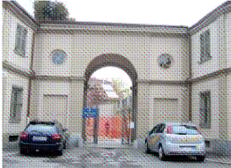
Via Fossano 8 ingresso
