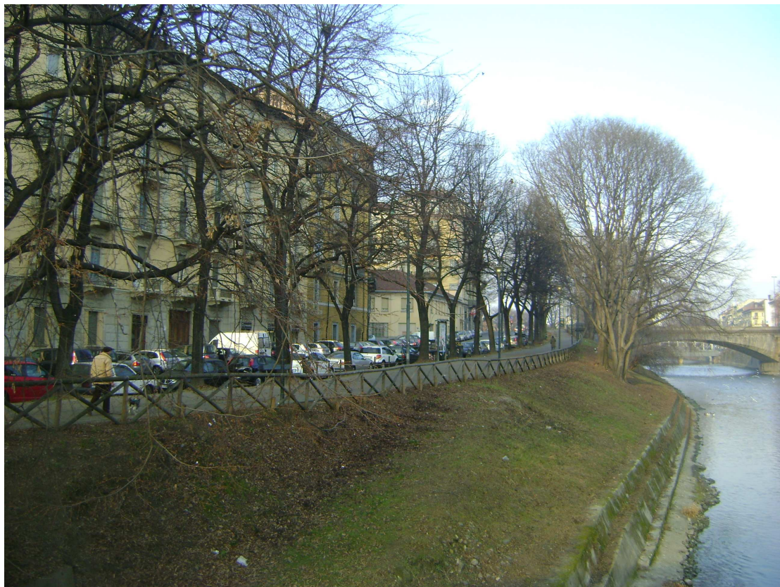
Sponda destra torrente Dora con vista verso ponte Mosca
