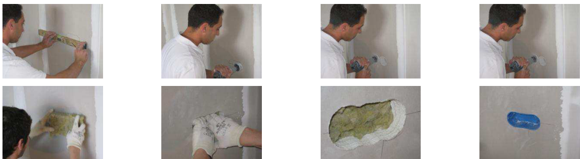
Figura 27. Partizioni leggere in cartongesso. Posa delle scatole elettriche.
