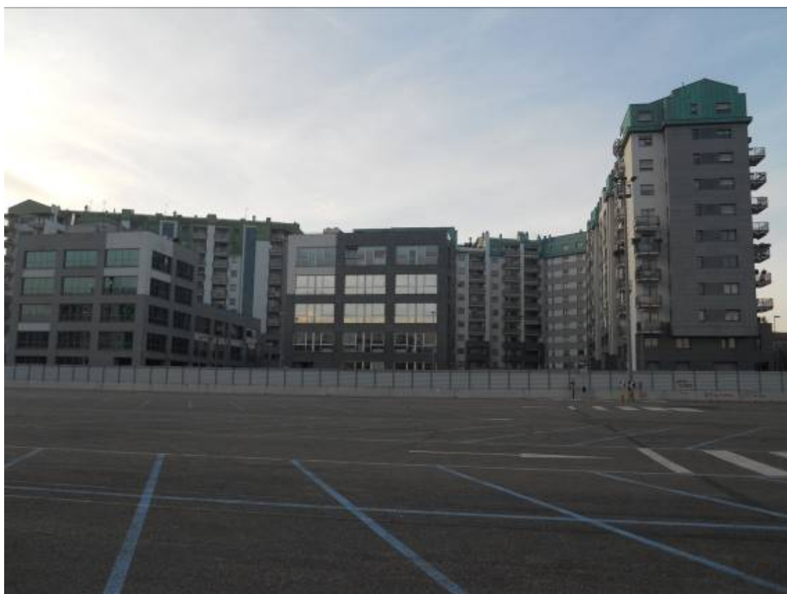
Foto 4. Vista parziale dell'area d'intervento (attualmente a parcheggio)
